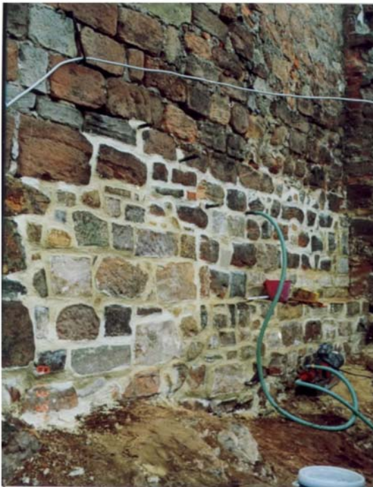
Bild 127: Testfläche mit Packern und Schraubenpumpe
