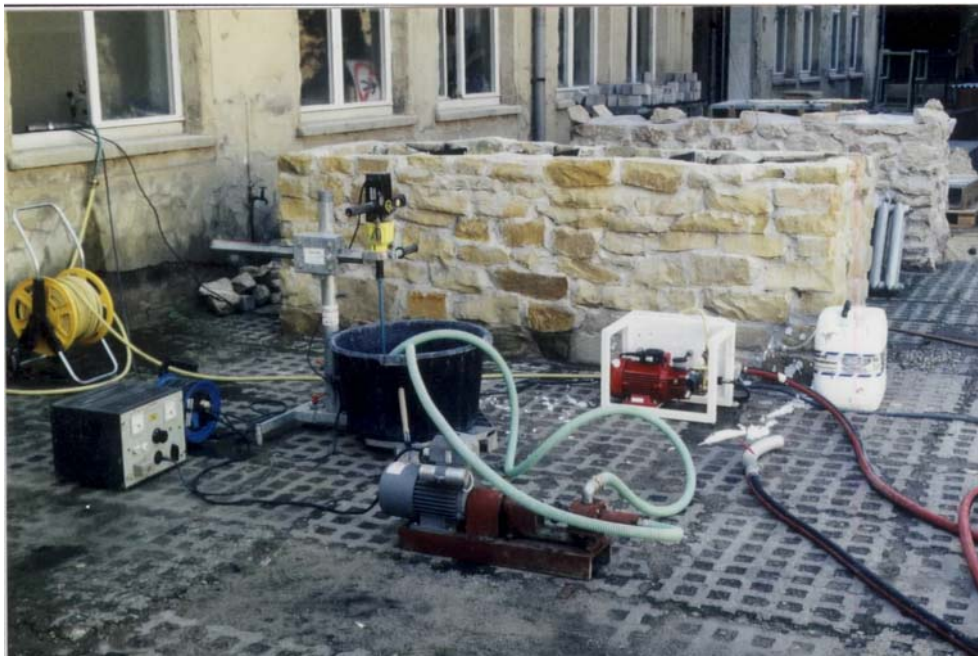
Bild 25: Geräteausstattung zur Schaummörtelherstellung in kleintechnischem Maßstab
