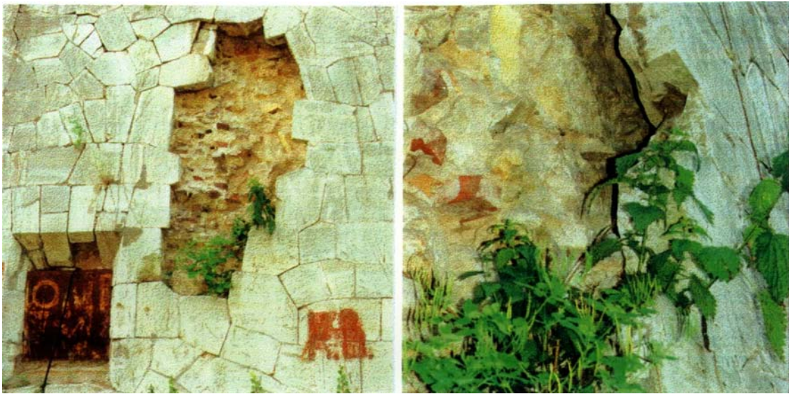
Bild 6: Vierschaliges Mauerwerksgefüge an der Nordfassade des Belvedere auf dem Pfingstberg in Potsdam
