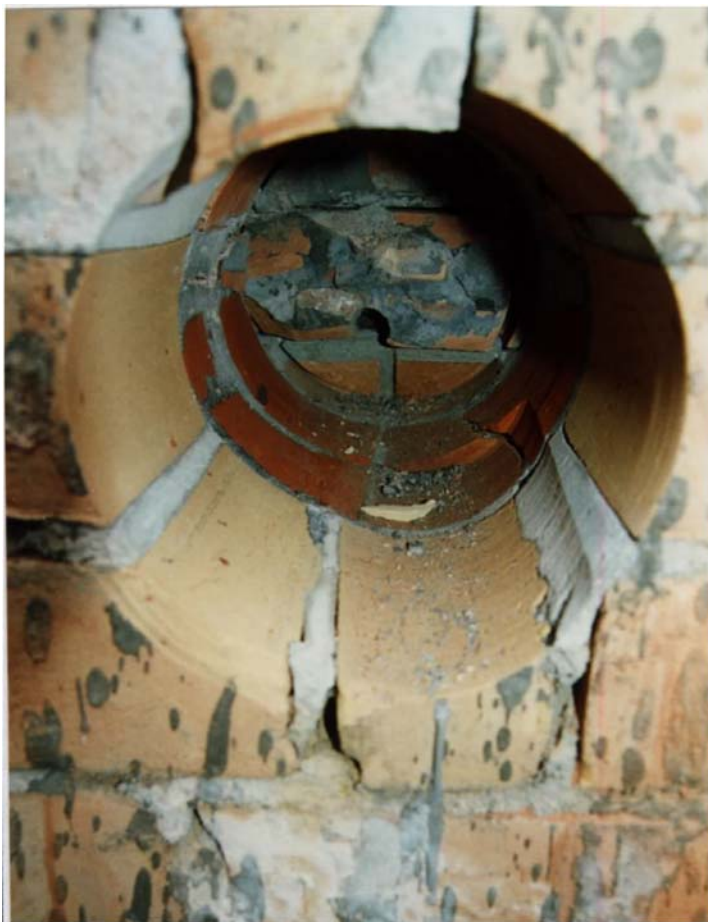
Bild 97: Ziegelmodellmauer nach der Bohrkernentnahme
