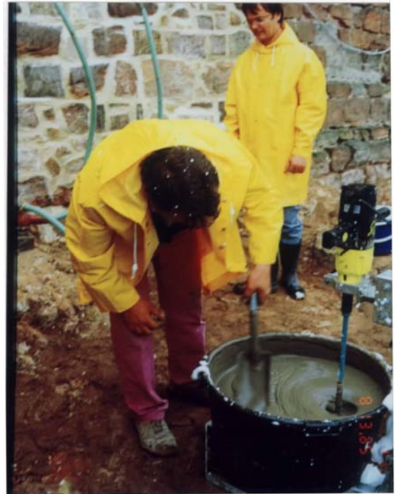
Bild 128: Während der Injektion
