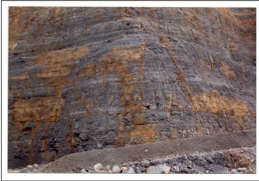
Bild 41: Keil als Unfallrisiko (Eigenaufnahme 11/00)
