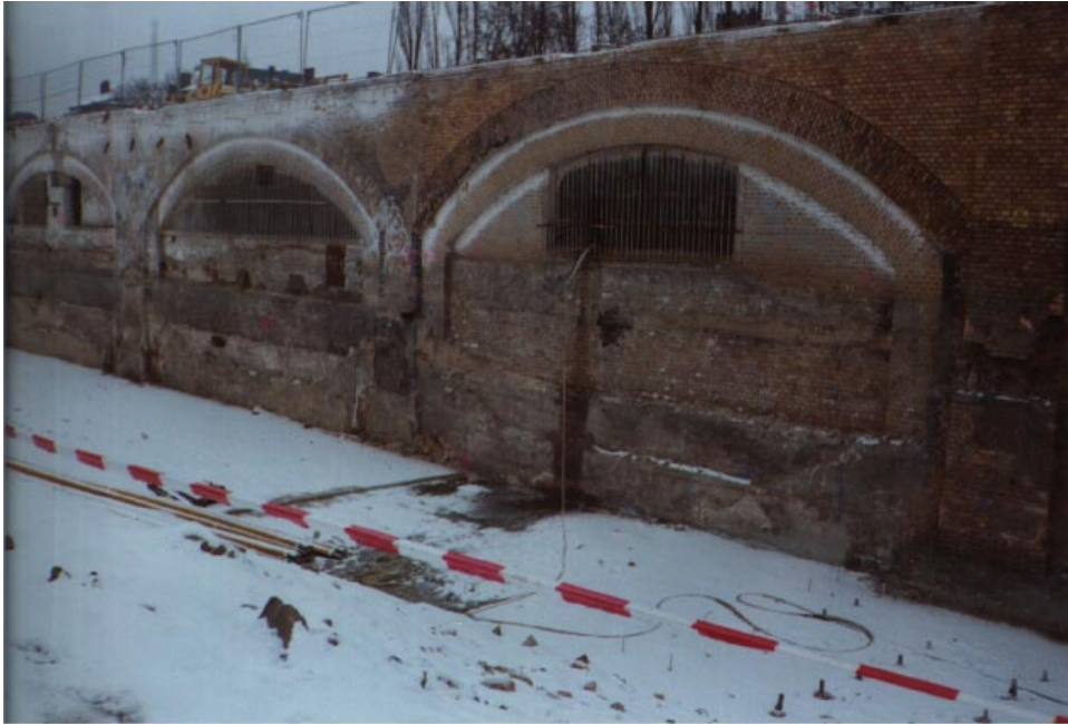
Bild 4: Blick auf den Viaduktabschnitt Bogen 272 bis 274
