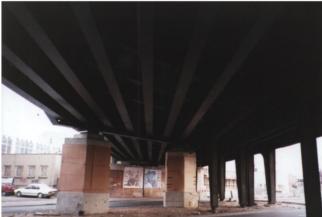
Bild 3: Unteransicht des fertiggestellten 1. Bauabschnittes
