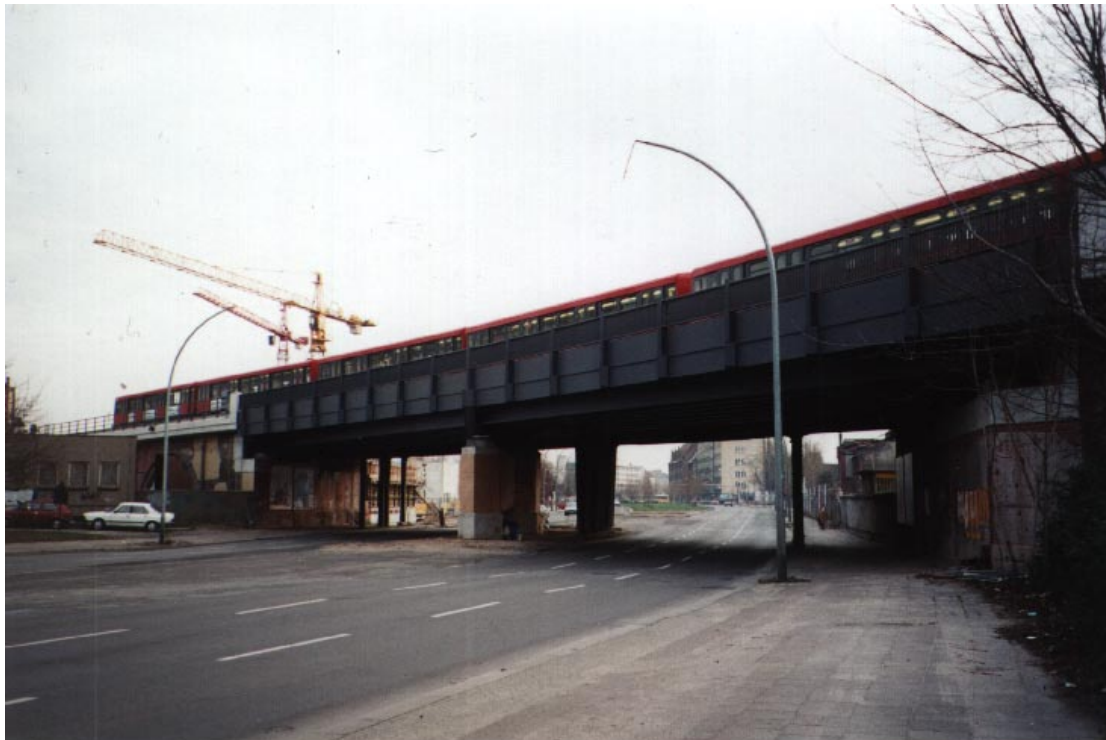
Bild 2: Eisenbahnbrücke über die Holzmarktstraße, Bauzustand im Dezember 1996
