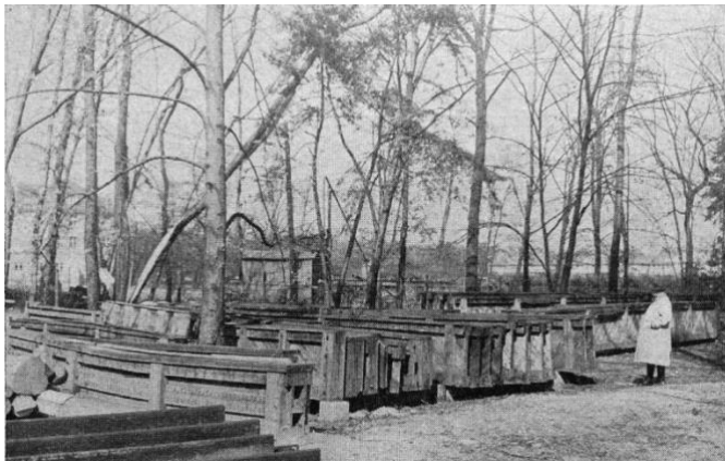
Bild 9 Vollwandige Holzbiegeträger im Bauhof der Versuchsanstalt in Karlsruhe.
