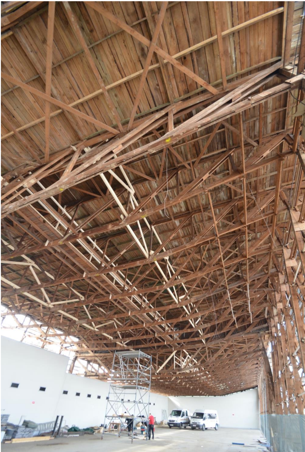
Bild 19 Erfurt, Fischbauträger der ega-Ausstellungshallen, Bj. 1959. Foto 2011
