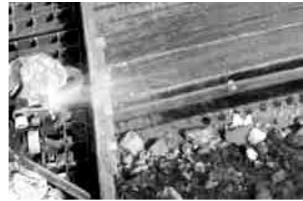
Bild 10 Annahmeförderer und Brecher
