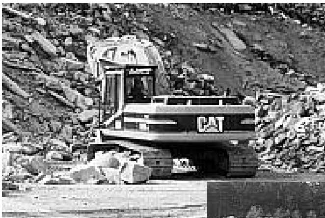
Bild 8 Vorzerkleinerung von Bauschutt
