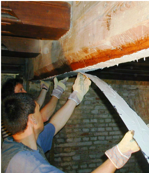
Abb. 7-8 Kleben der CFK-Lamellen
