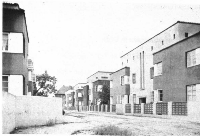
3 Die erste Siedlung des Neuen Bauens: Italienischer Garten, Celle 1924
