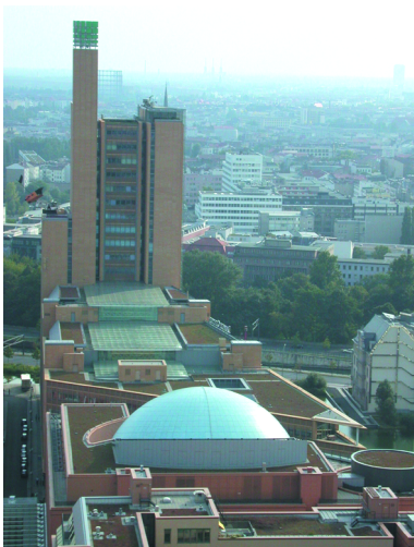
Abb.56 IMAX-Kino Berlin, Dachaufsicht
