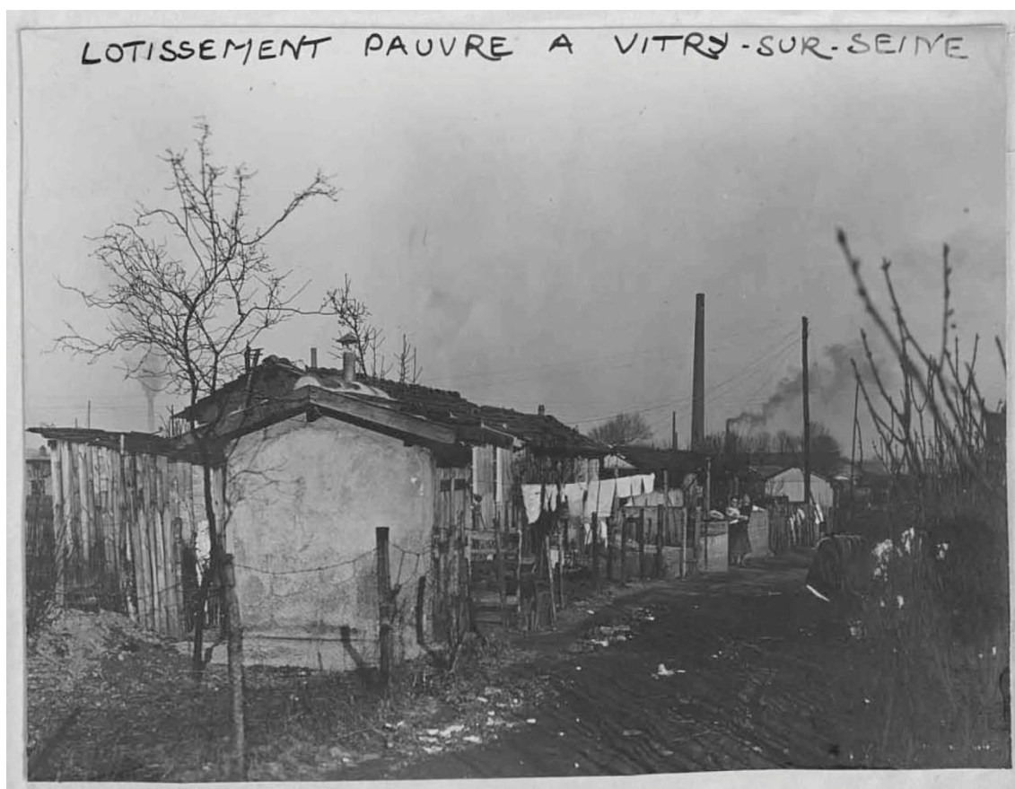
Photo 32. Lotissement défectueux in Vitry-Sur-Seine. Source: (Proquitte, 1930, p. 41).
