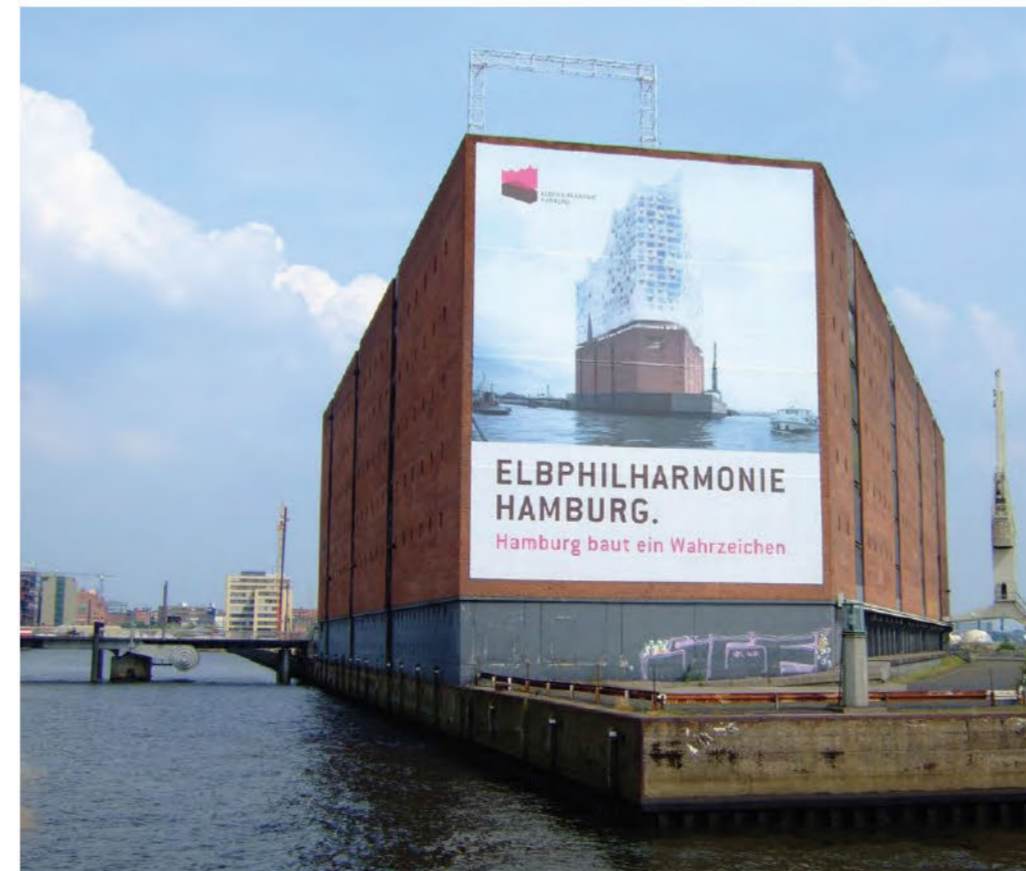
JohnSeb, 7 July 2006. "Kaispeicher A Anfang der 2000er Jahre, geschmückt mit einem großen Werbeplakat der Telekom. Erbaut wurde er 1963 anstelle des im 2. Weltkrieg zerstörten Kaispeichers auf 1111 Betonpfählen." "Hamburg Und Mehr - Elbphilharmonie: Kaispeicher A," Available from: Wikipedia Commons, https://commons.wikimedia.org/wiki/File:Kaispeicher_A_mit_Plakat_Elbphilharmonie.jpg (accessed September 12, 2019.) Copyright: Attribution-ShareAlike 2.0 Generic (CC BY-SA 2.0)
