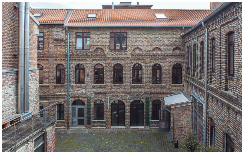
Blick auf den Kernbau. Foto 2019
