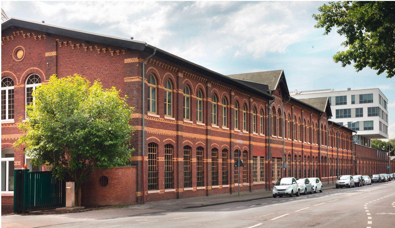
Tuchfabrik Leopold Schoeller, Straßenansicht mit Neubau. Foto 2019
