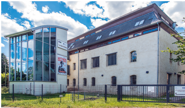
Tuchfabrik Müller, Euskirchen, Neuer Treppenturm nach Konversion
