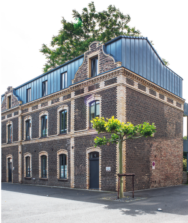
Aufstockung des ehemaligen Kontorhauses nach der Konversion. Foto 2019
