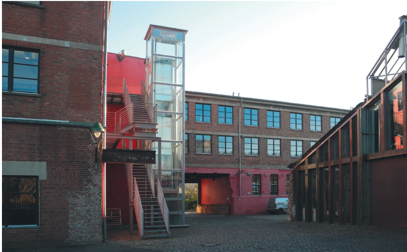
Blick auf die neue Treppenanlage, die neue Fassade des Lagerbaus und im Hintergrund die Weberei. Foto 2018
