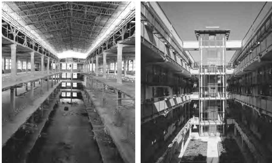
Abb. 2, 3: Buntgarnwerke: links: Hochbau Süd nach dem Einschnitt; © Fuchshuber Architekten; rechts: Hochbau Süd nach der Konversion; © Hans-Christian Schink.
