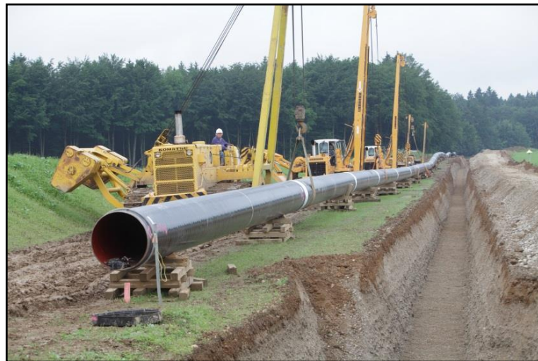
Abbildung 2: Verlegung im Graben (Foto VEENKER)
