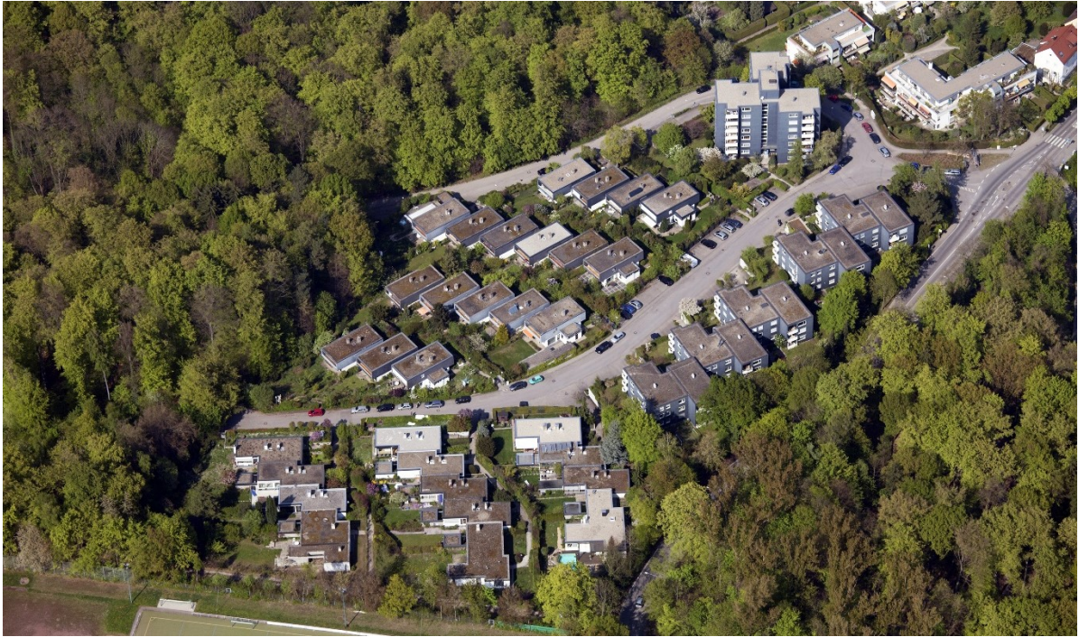
43 Das Luftbild zeigt die Siedlung Aspen mit unterschiedlichen Bautypologien.
