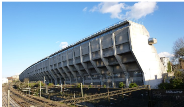
83 Städtebaulich passt sich Alexandra Road Estate den seitlich verlaufenden Bahngleisen an.
