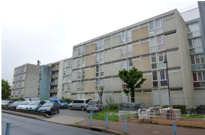
73, 74 Vor Beginn der Sanierungsarbeiten litt die Siedlung unter jahrelang mangelndem Unterhalt.
