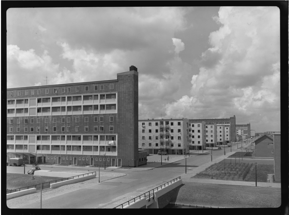
87 Die Aufnahme von 1959 zeigt die Bebauung kurz vor Fertigstellung.
