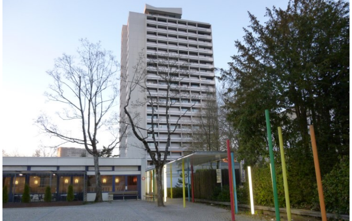
67 Das Quartierzentrum bildet einen wichtigen Begegnungsort für die Bewohner.
