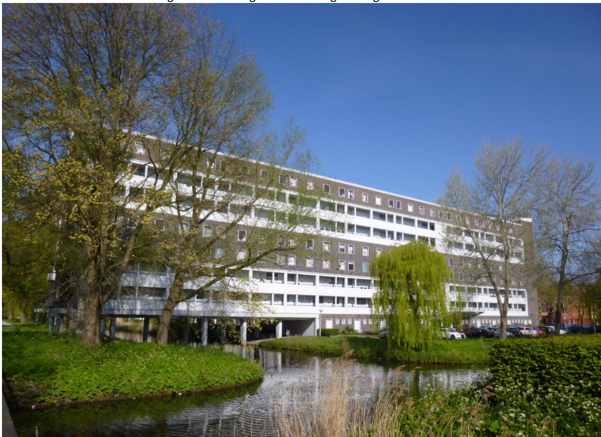
88 Auf der von der Straße abgewandten Seite sind die Wohngebäude teilweise aufgeständert und kragen über die Siergracht.
