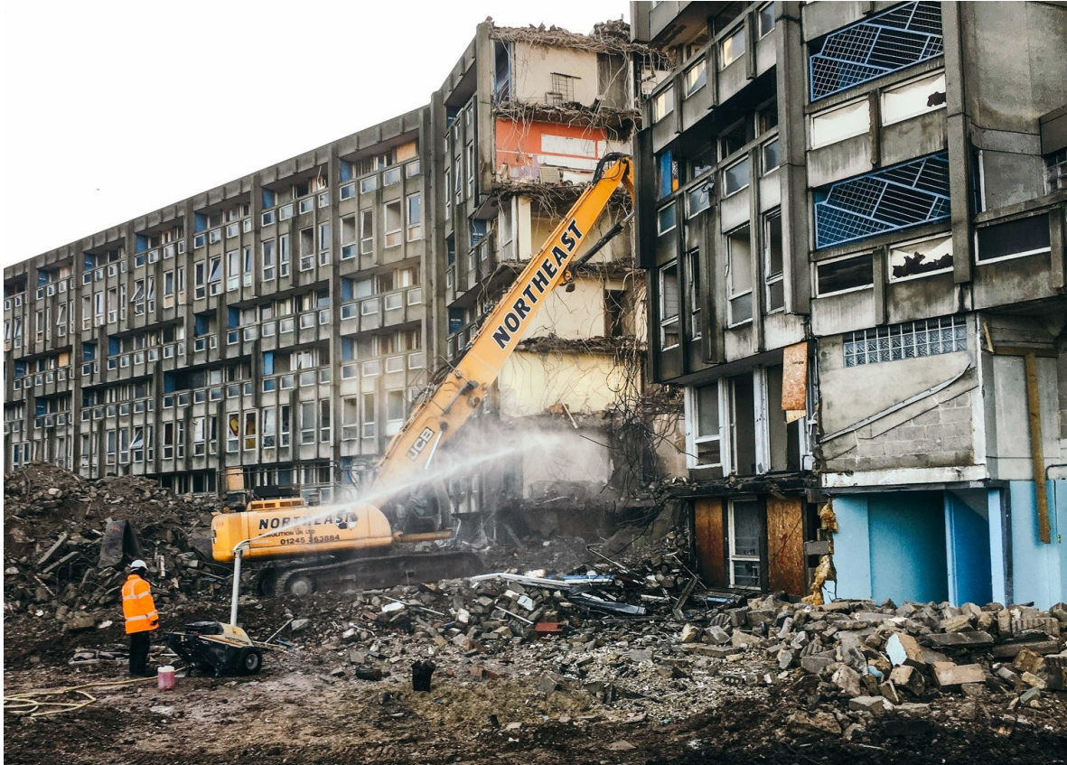
78 Trotz zahlreicher Widerstände wurde Robin Hood Gardens 2017 abgerissen.
