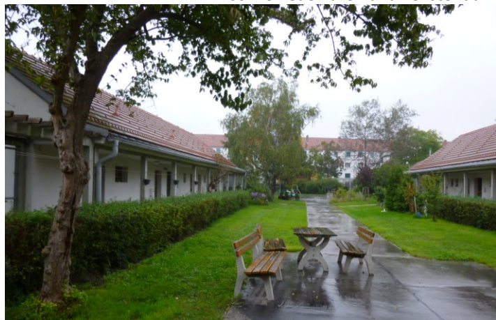
59 Die Siedlung umfasst unterschiedliche Bautypologien wie hier beispielsweise Altenwohnungen.
