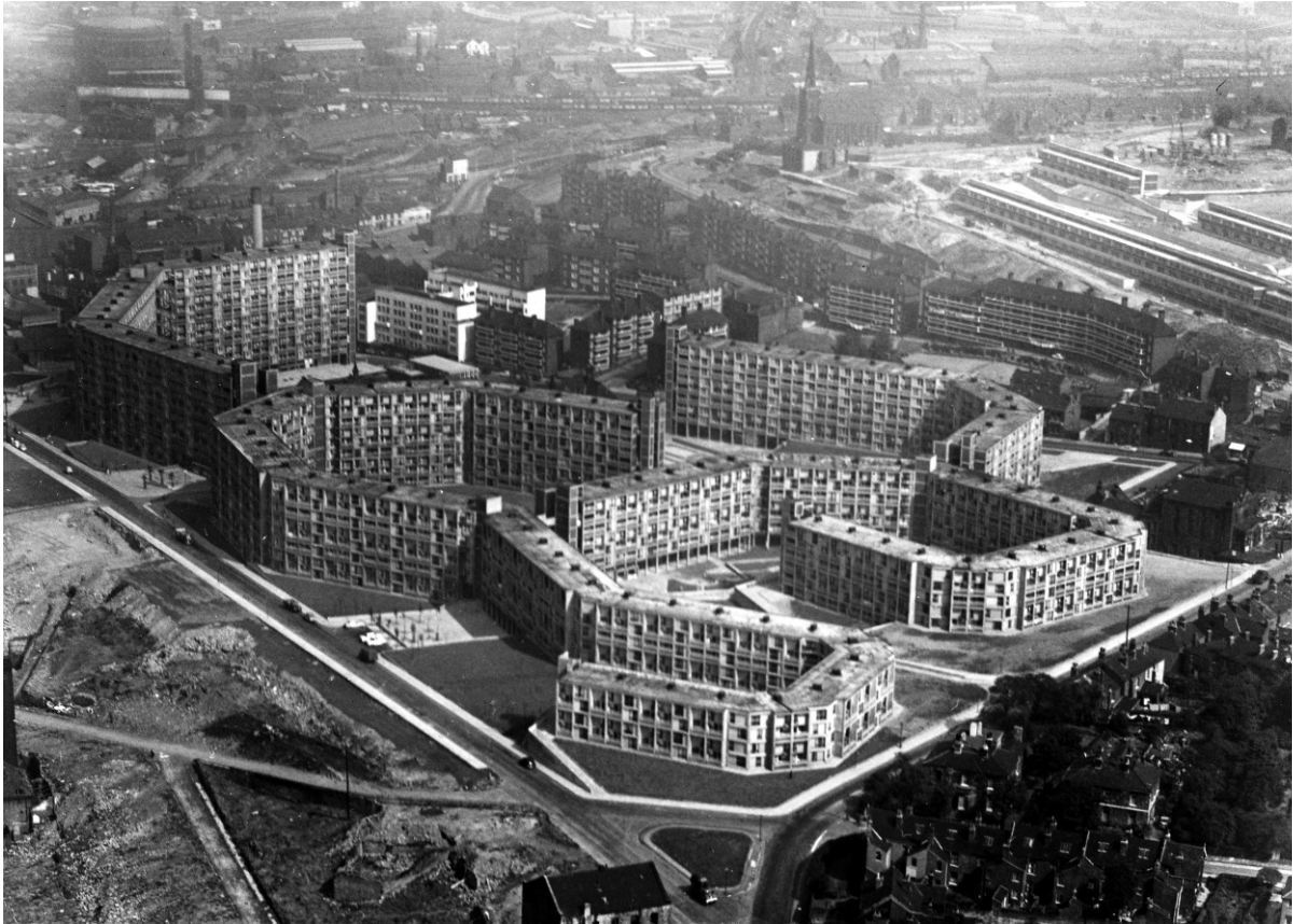
86 Die Luftaufnahme von 1960 zeigt Park Hill in erhöhter Lage mit polygonaler Bebauungsstruktur als Landmark.
