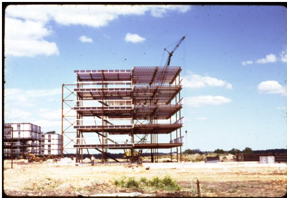
5 Errichtung der experimentellen Stahlkonstruktion von La Grand'Mare als industriell gefertigte, modulare Konstruktion.
