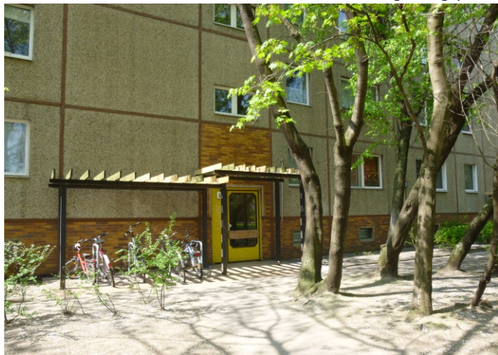
48 Original erhaltener Hauseingang.
