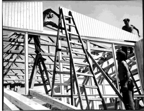
30 Die originale Dachkonstruktion der Gebäude bestand aus Nagelbindern mit Wärmedämmung und Aluminium-Rolldach.
