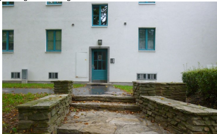
58 Die Wohngebäude weisen inzwischen Fassadendämmungen sowie neue Türen und Fenster auf.
