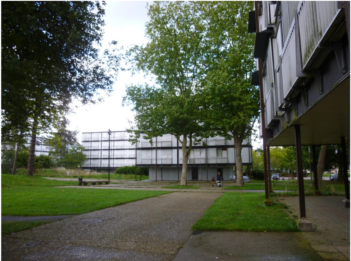
71 Das Grundgerüst der auf Stützen ruhenden Wohnbauten besteht aus Korten-Stahlrahmen, die Fassaden sind mit Aluminium- und Glas-Elementen verkleidet.
