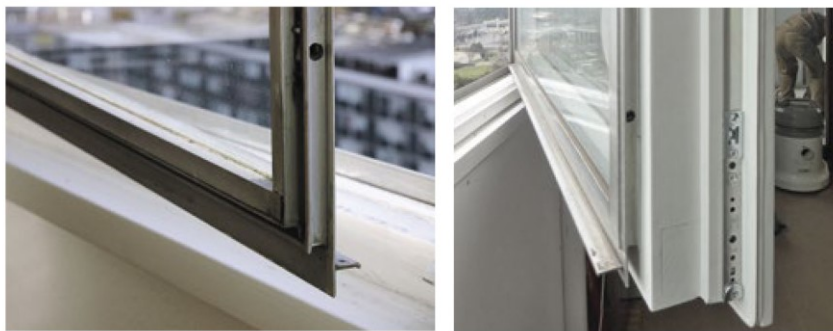
33 Fensterdetail vor und nach der Sanierung.
