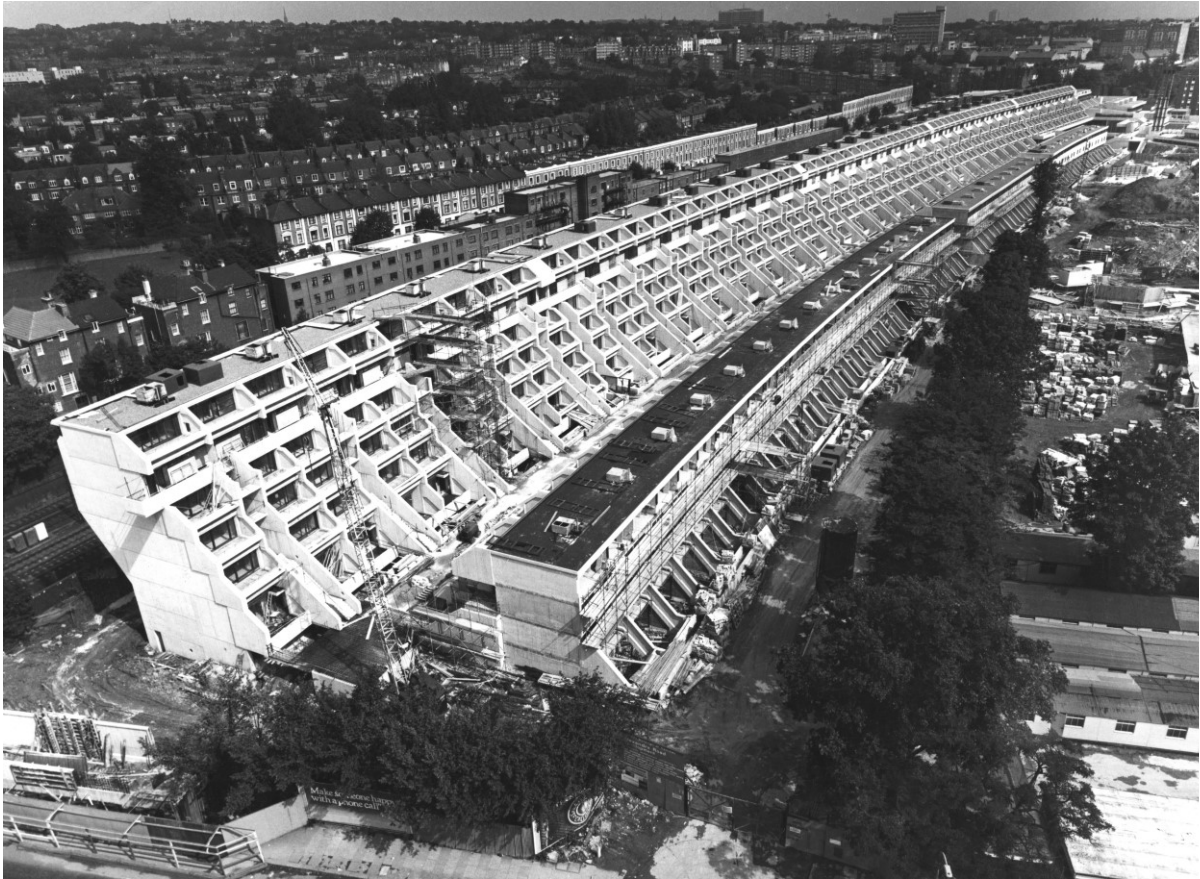
81 Die Luftaufnahme zeigt Alexandra Road Estate während der Bauphase.
