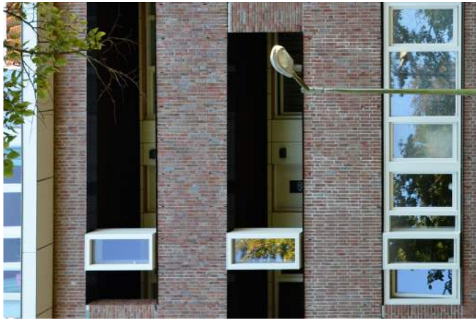
ABB. 17 „Fenster“ am Laubengang
