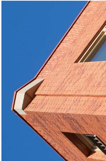
ABB. 21 zierender Fassadenabschluss, Heren5
