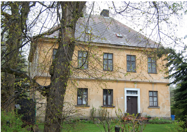
Abb. 63: Ehemaliges Schulgebäude, heute Nutzung als Ferienhaus, Mai 2010
