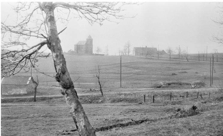
▲▲ Abb. 58: Ehemaliger Hof Nr. 44 in bereits ruinösem Zustand, 1964
