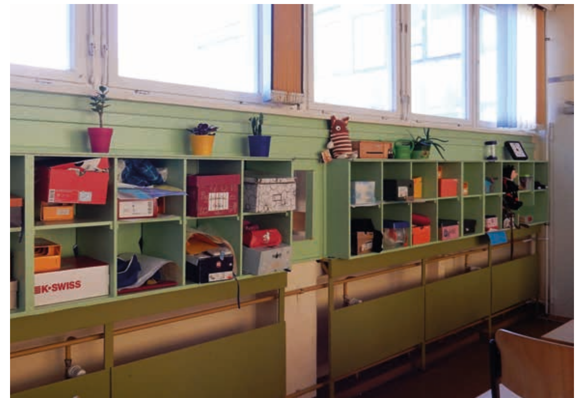
↑ 15: Die Einbauschränke und Heizkörperverkleidungen stammen aus der Entstehungszeit der Schule und werden nach restauratorischem Befunde wieder in der ursprünglichen Farbe gefasst.
