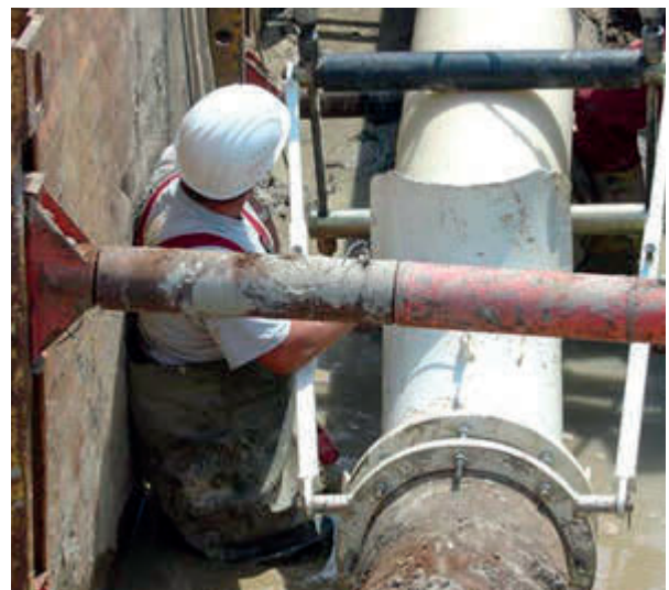
Abb. 4.65: Einbringen des Gewebeschlauches in Altrohrleitung
