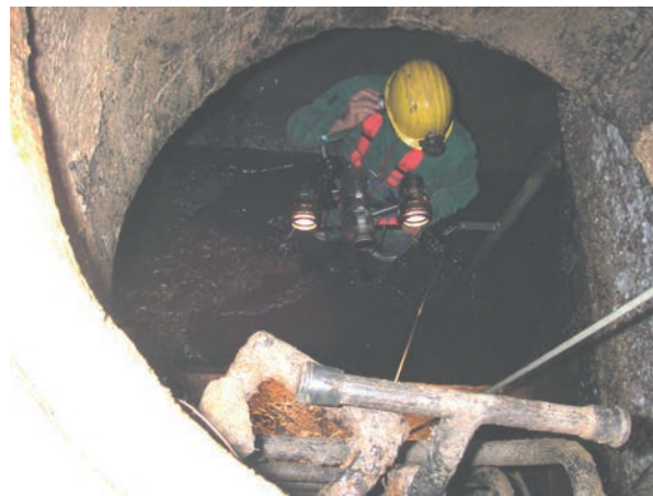
Abb. 7.7: Kanalbegehung: Inspekteur der ISAS GmbH [Bosseler und Sokoll, 2007]
