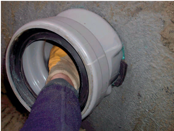
Abb. 7.20: Einbau eines Anschlussformteils bzw. Anschlussstutzens (aus [Kaltenhäuser, 2006])
