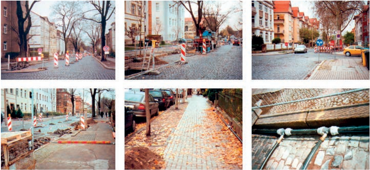
Abb. 4.58: Erfurt Baustellensicherung und Ersatzversorgung – Beispiele a) b) c) Verkehrssicherung d) e) f) Ersatzversorgung
