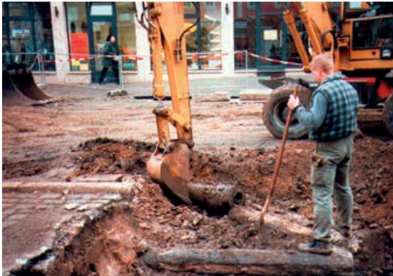
Abb. 3.7: Bergung von Holzrohrleitungen in der Innenstadt von Weimar 1999
