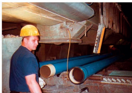
Abb. 3.17: Korrosionsschutz von Stahlrohren - Werkstoffverbund
