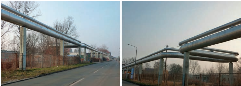
Abb. 8.47: Erfurt Stützenleitung (links); Ausdehnungsbogen (rechts)
