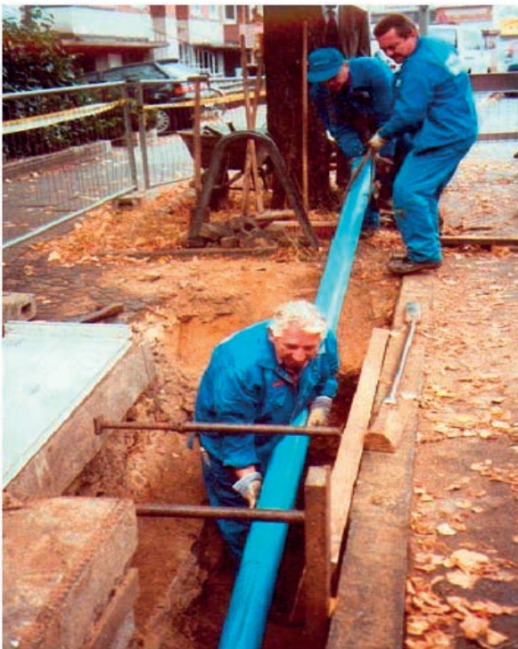
Abb. 4.93: Einbringen der Stahlrohre in die Baugrube
