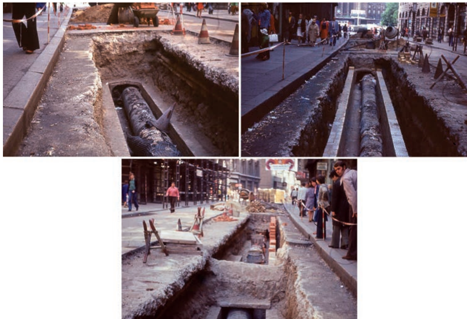
Abb. 8.56: Fernwärmeleitungen – Rekonstruktionsmaßnahme in der Innenstadt von Leipzig (Bilder Roscher in den 80er Jahren)
