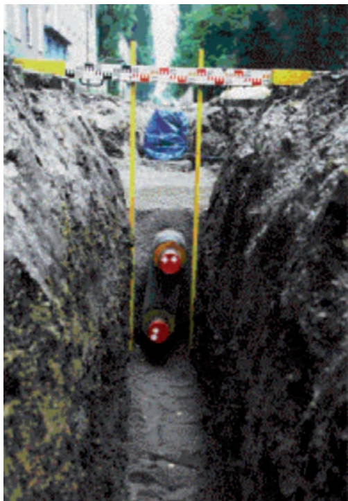
Abb. 1.40: Querschnitt einer Fernwärmetrasse in Weimar
