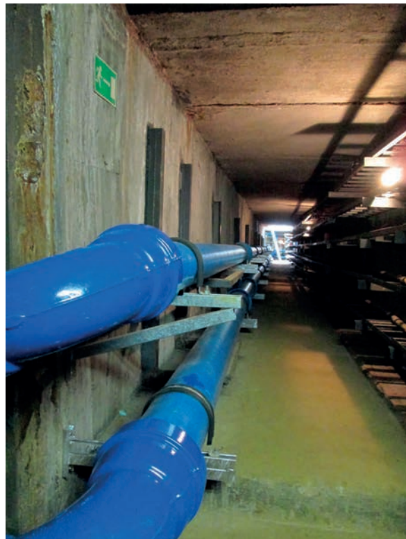
Abb. 8.59: Neue Leitungen im Sammelkanal [Rau, 2014]
