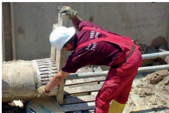
Abb. 4.63: Abkopplung der Drucktrommel nach erfolgreicher Installation
