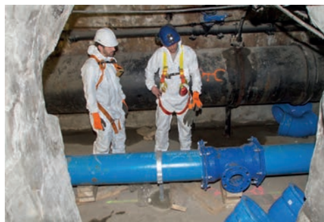
Begutachtung der neuen Leitung
