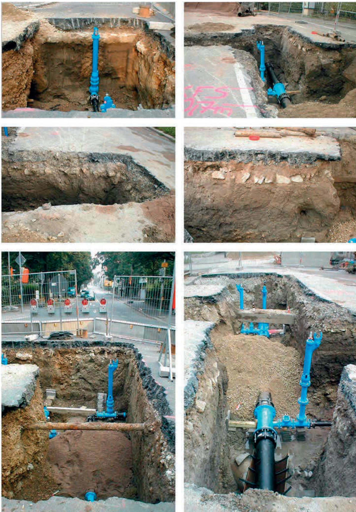
Abb. 1.16: Straßendeckenaufbau und Verfüllung beim Einbau von Armaturen
