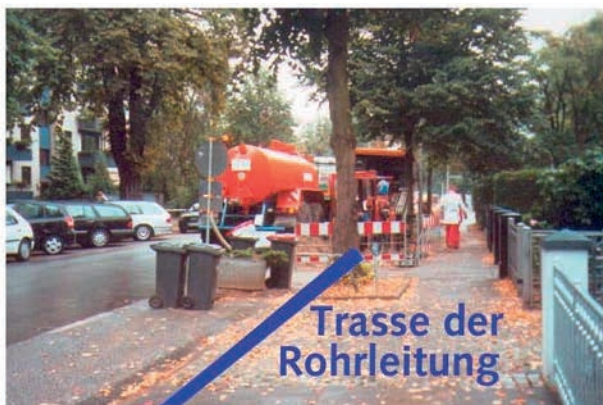
Abb. 1.9: Schonung des Baumbestandes durch Neuverlegung mit steuerbarem Vortrieb unter einer Baumreihe (vgl. Kap. 4.9.7 Steuerbarer grabenloser Vortrieb)
