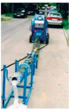
Abb. 4.66: Verfahrensschritte des Gewebeslauchverfahrens
