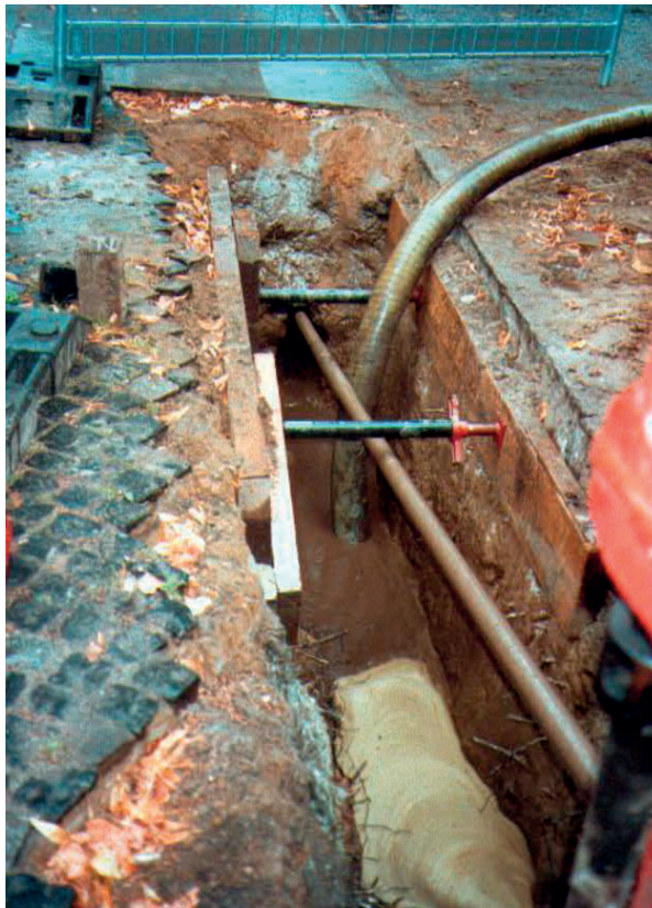
Abb. 4.95: Absaugen der Stützflüssigkeit in der Startgrube
