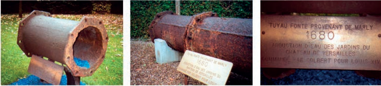
Abb. 3.9: Gussrohrleitung der Wasserversorgung der Gärten und Fontänen des Schlosses Versailles 1680 (Fotoaufnahmen in Pont a Mousson)
