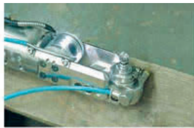
Fräsroboter zum grabenlosen Öffnen vorhandener Abgänge
