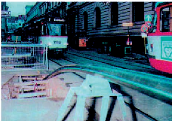
Abb. 5.7: Rolldown-Verfahren in einer Verkehrsstraße in Halle [N.N., 2002]; In der Rolldown-Maschine wird der Durchmesser des Inliners vor dem Einzug verringert
