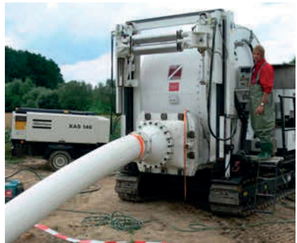
Abb. 4.64: Reversionsvorgang mit mobiler Drucktrommel für Gewebeschläuche bis 600 m
