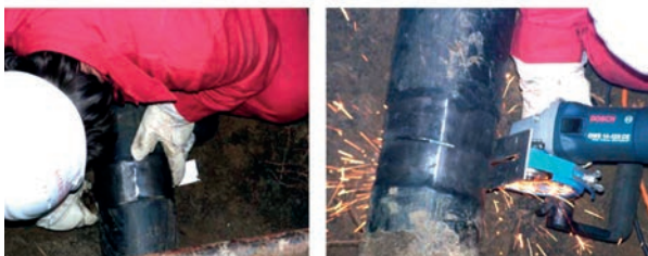
Abb. 4.85: Schutzblech zwischen PE-Rohr und alter Stahlleitung einschieben, Anchnitt (80 % der Wanddicke) mit speziellem Winkelschleifer (mit Tiefenbegrenzer)
