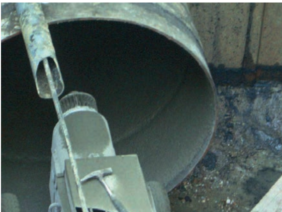
Abb. 4.60: Zementmörtelauskleidungsmaschinen
