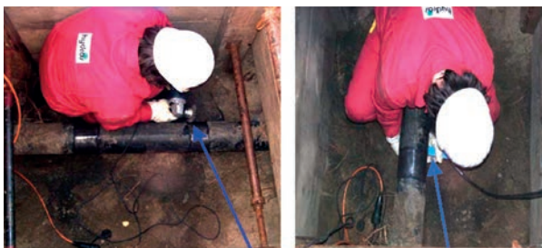
Abb. 4.84: Entfernen der Rohrumhüllung mit Topfbürste und Rohrspalt hydraulisch aufspreizen
