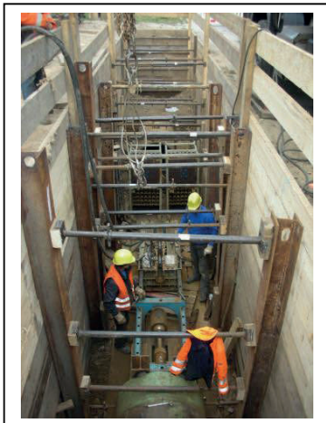
Rohreinzug PE DN 800 in St DN 1000
