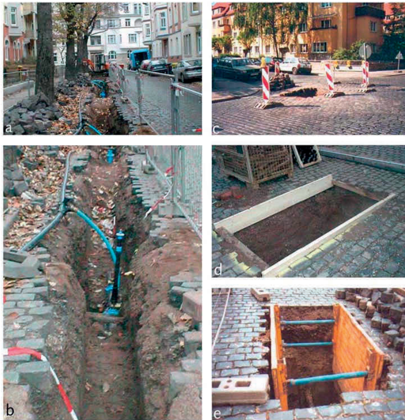
Abb. 1.15: Baugrubensicherung
