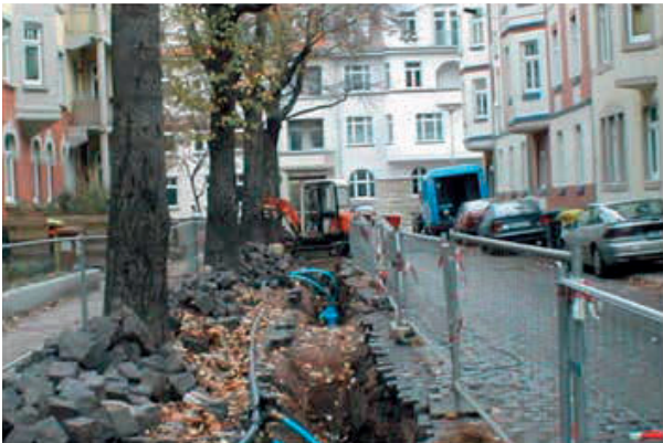
Abb. 1.7: Schädigung des Wurzelbereiches durch „konventionelle“ Neuverlegung
