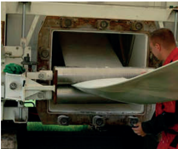
Abb. 4.62: Aufwickeln des klebstoffgefüllten Gewebeschlauchs in der Drucktrommel
