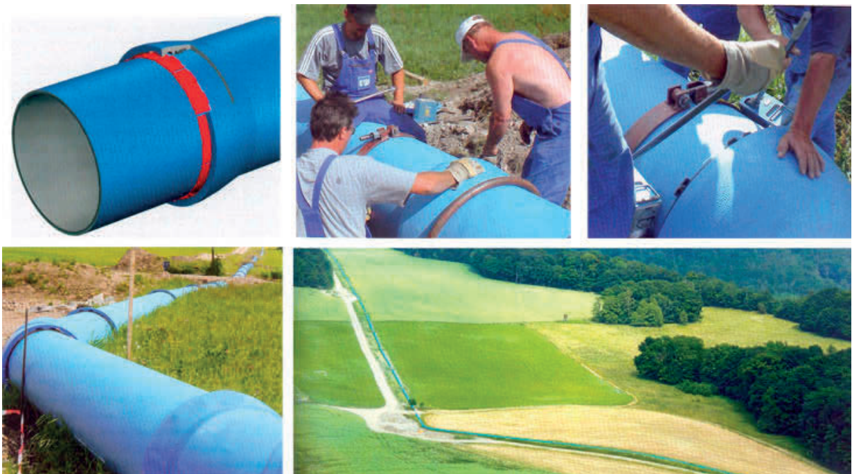
Abb. 4.103: Interimsleitung mit längskraftschlüssiger BLS-Steckmuffenverbindung
