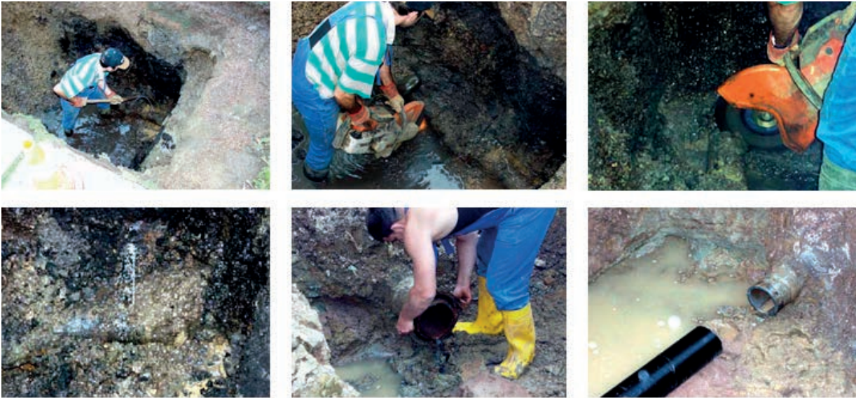
Abb. 4.27: Freilegen der Schadstelle/Rohrtrennung
