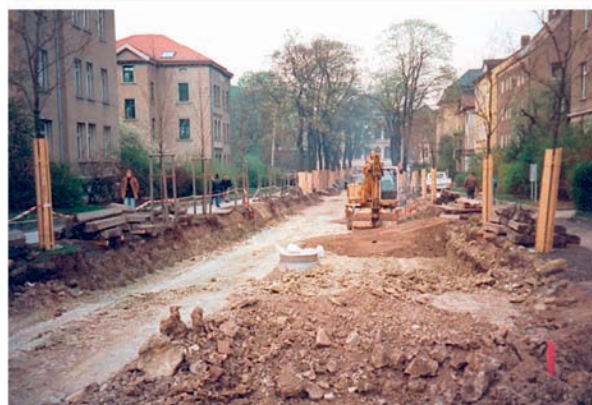
Abb. 1.6: Straßenerneuerung und Baumschutz
