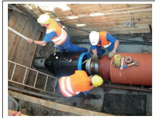
Einbau des des ersten Rohres
