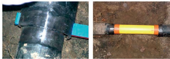
Abb. 4.86: durch weiteres hydraulisches Aufweiten wird die vorgeschrittene Sollbruchstelle gebrochen, Freier Rohrabschnitt nach Herausnehmen der aufgeweiteten Stahlhaube sowie beidseitig eingeführter Kantenschutz mittel Kunststoffschalen
