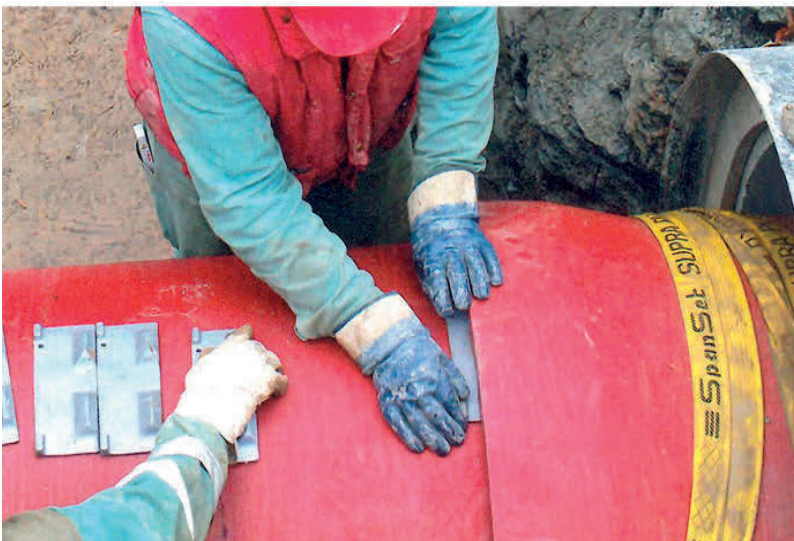
Abb. 4.104: Einziehen von Duktulgussrohrleitungen
