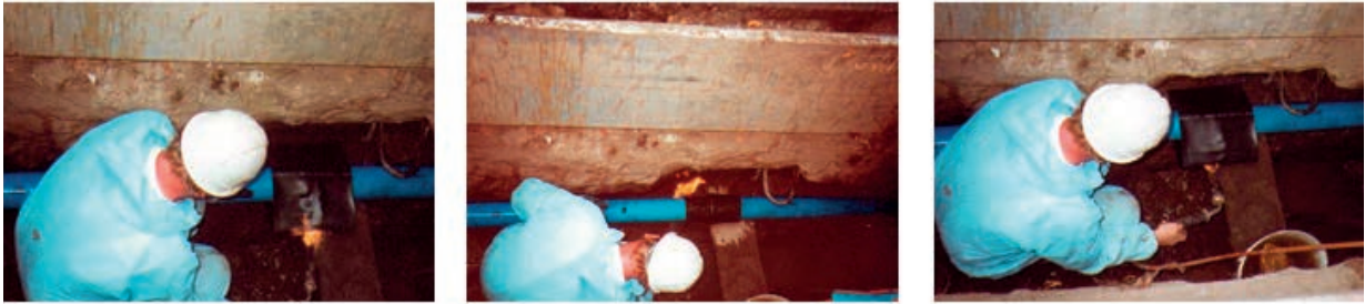
Abb. 4.94: Aufbringen der Schrumpfmuffe zum Korrosionsschutz
