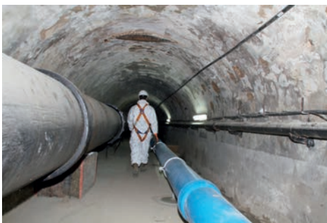
Rückbau der alten Leitung
