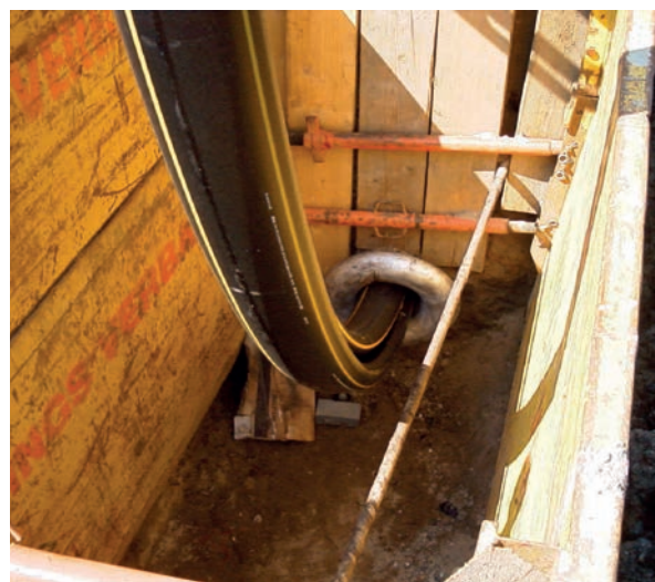
Abb. 4.74: Einziehen des U-Liners
