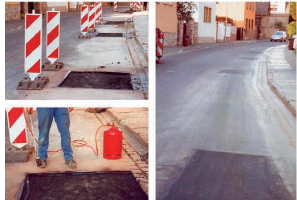
Abb. 1.27: Einbau von bituminösem aufschmelzbarem Fugenband zur Wiederherstellung der Straßendecke nach Armaturenwechsel
