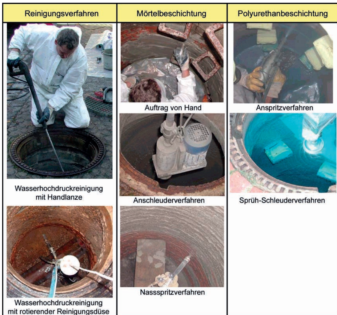
Abb. 7.26: Bei In-situ-Maßnahmen [Bosseler und Puhl, 2005] untersuchte Beschichtungs- und Reinigungsverfahren
