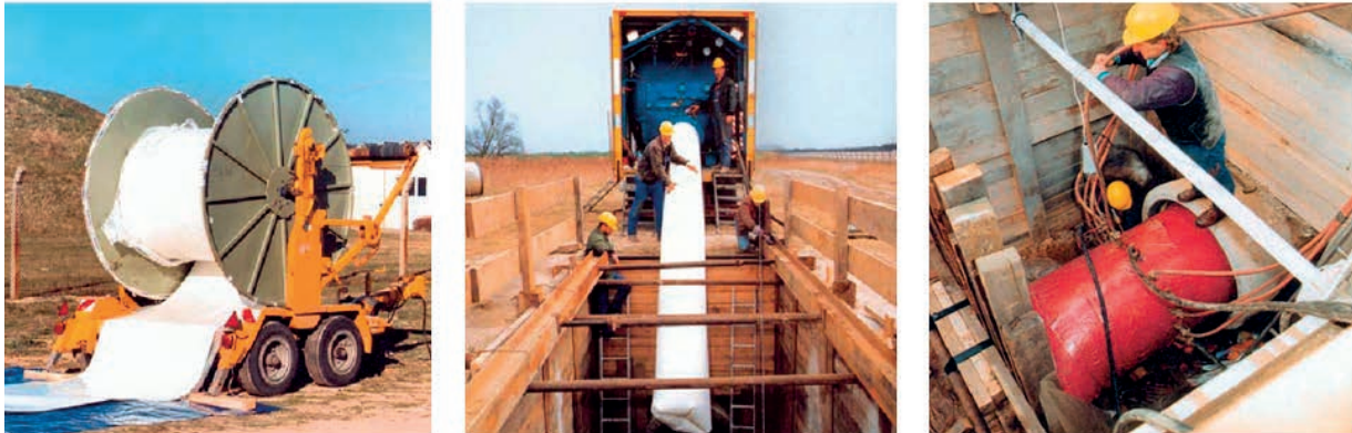
Abb. 4.67: 1 Rollenwagen mit Gewebeschlauch, 2 Einbringen des Gewebeschlauches, 3 Gewebeschlauch in der Zielgrube
