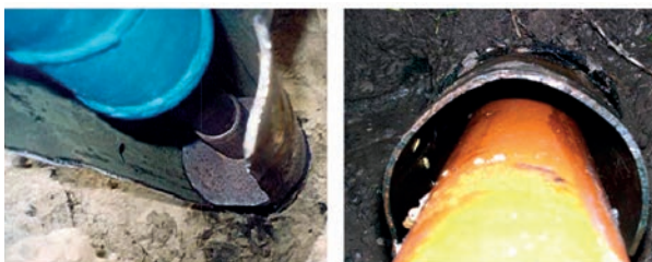
Abb. 4.83: Hausanschlussleitungen werden nachträglich eingebunden; dafür werden Standardbauteile und Armaturen verwendet
