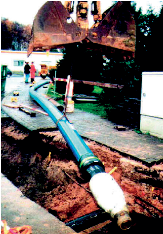
Abb. 5.16: ausgelegtes Rohr kann eingezogen werden
