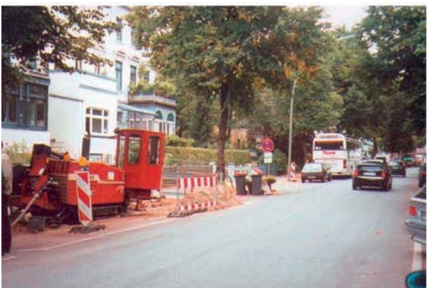
Abb. 1.9: Schonung des Baumbestandes durch Neuverlegung mit steuerbarem Vortrieb unter einer Baumreihe (vgl. Kap. 4.9.7 Steuerbarer grabenloser Vortrieb)
