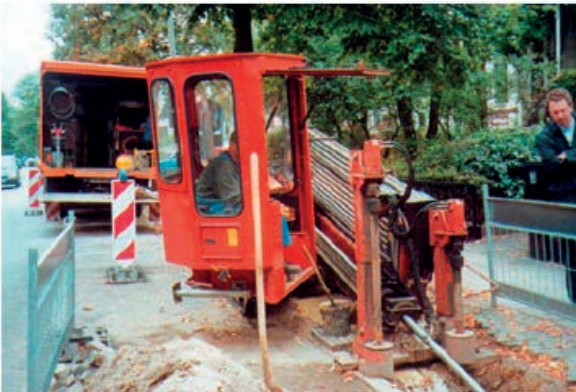
Abb. 4.92: Neuverlegung einer Wasserrohrleitung
