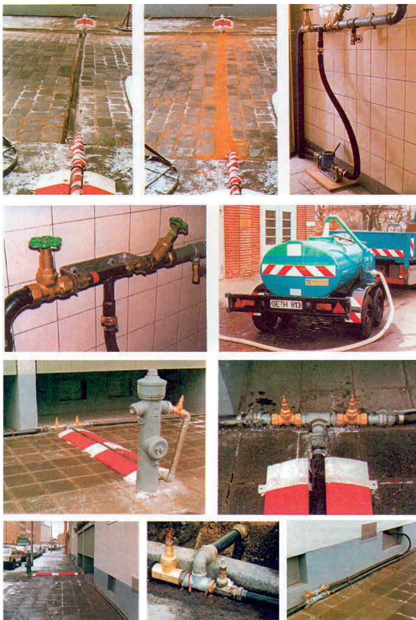
Abb. 4.57: Ersatzversorgung nach W 394 -Beispiele
