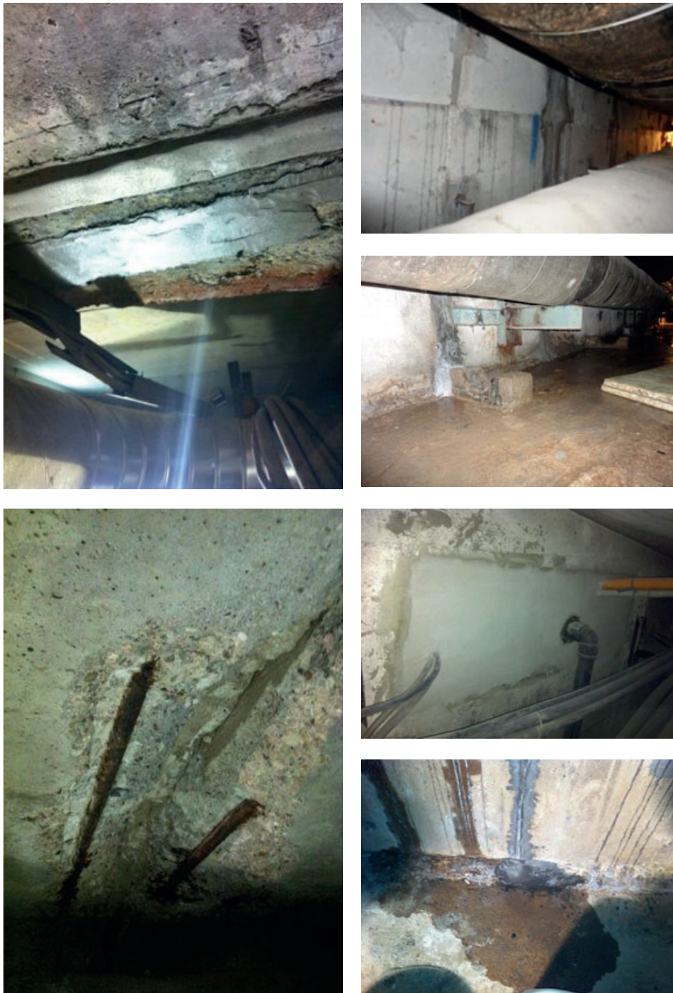
Abb. 8.61: Sammelkanal Suhl: Instandsetzung der Kanalstrecke durch Abstemmen von hohlliegenden und losen Bestandteilen der Betonteile sowie Wiederherstellen des Bestandes durch Reprofilierung der Schadstellen mit Kunststoff modifizierten Zementmörtel (PCC); Sammelkanal Jena: Abdichtende Verpressung mit PU-Injektionsharz [Breternitz GmbH, o.J.]
