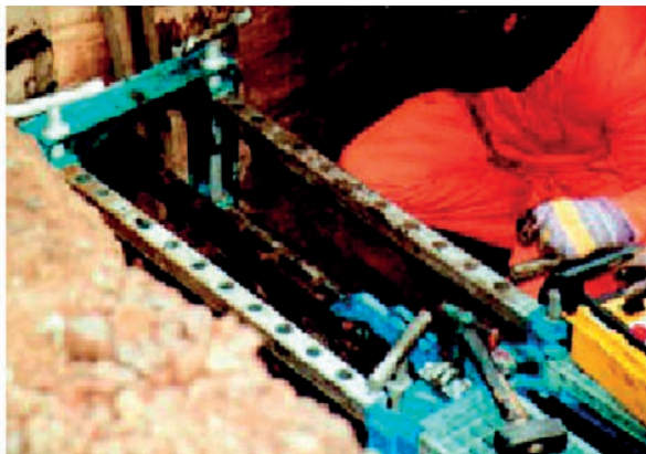
Abb. 5.14: Berst-Maschine; Ankoppeln
