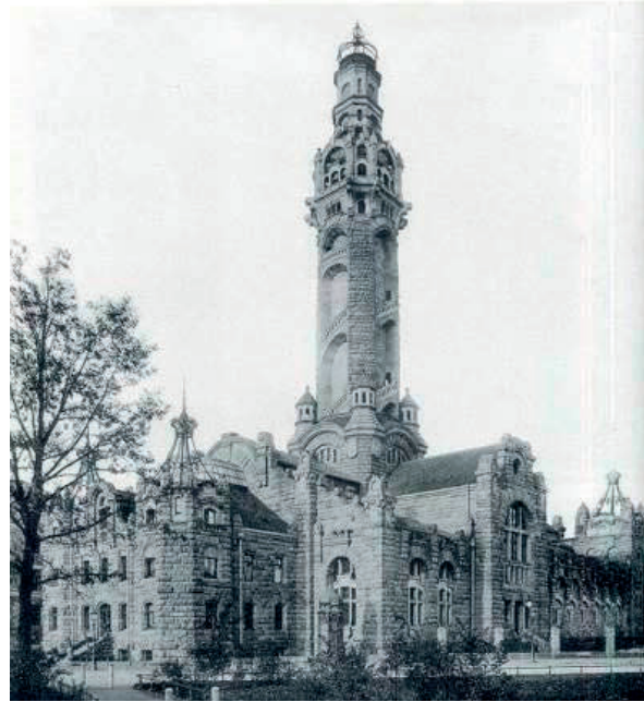
Abb. 8.6: Dresden Heizwerk [Geier, 1978]
