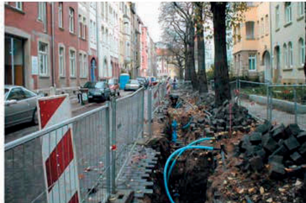
Abb. 1.7: Schädigung des Wurzelbereiches durch „konventionelle“ Neuverlegung
