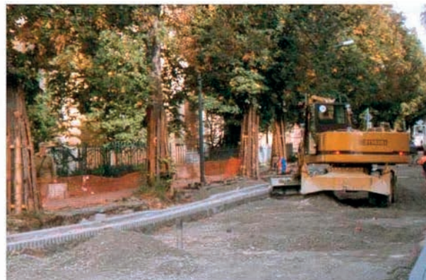
Abb. 1.7: Schädigung des Wurzelbereiches durch „konventionelle“ Neuverlegung
