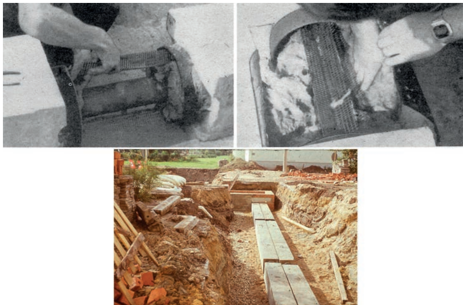
Abb. 8.40: Framitherm-Rohre – Herstellung der Rohrverbindungen [Fröhlich, 1989], [Wossog, 1989], [Roscher, 1989]
