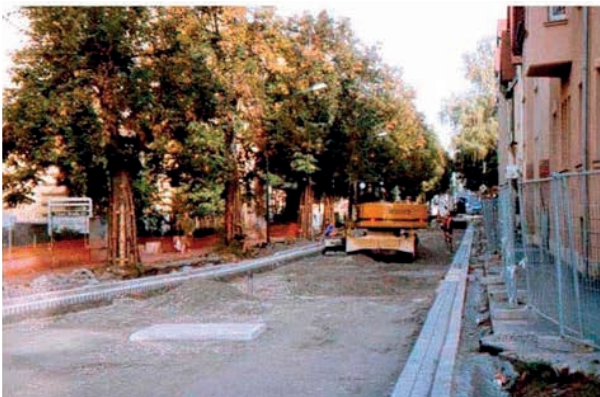
Abb. 1.8: Baumschutz bei Straßenbauarbeiten
