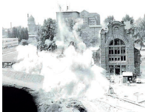
Abb. 8.5: Dresden - Sprengung des Heizwerkes [Geier, 1978]
