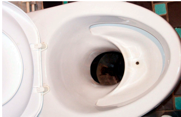
Abb. 7.21: Separationstoiletten Wohnkomplex Gebers bei Stockholm (Foto Oldenburg)
