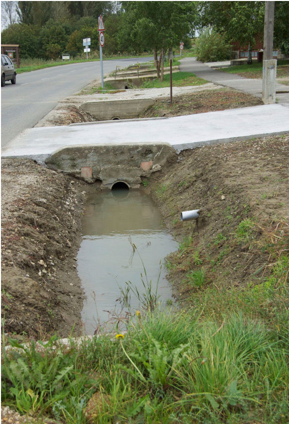
Abb. 11.1: Wegeseitengraben innerhalb einer Ortschaft in Ungarn (Bild Londong)
