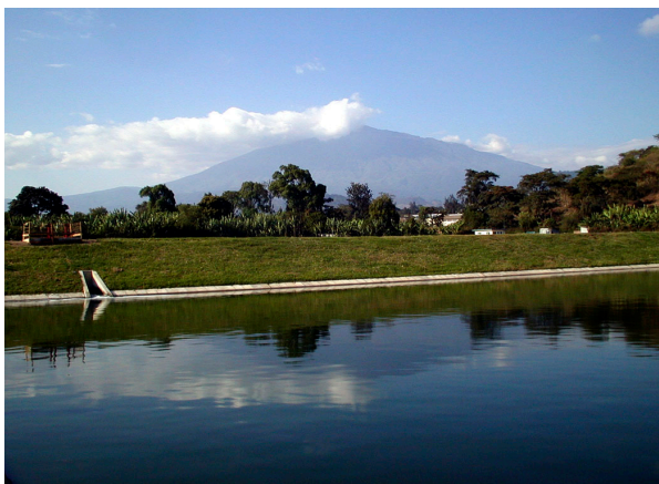
Abb. 5.3: Abwasserteichanlage in Arusha, Tansania 2002 (Bild: Rustige)
