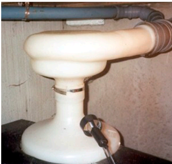
Abb. 7.12: Spültoilette mit Feststoffabscheidung und nachgeschalteter Kompostierung [Aquatron, 2003]
