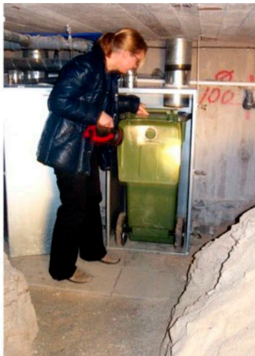
Abb. 7.22: Fäkalientonnen Wohnkomplex Gebers bei Stockholm (Foto Oldenburg)
