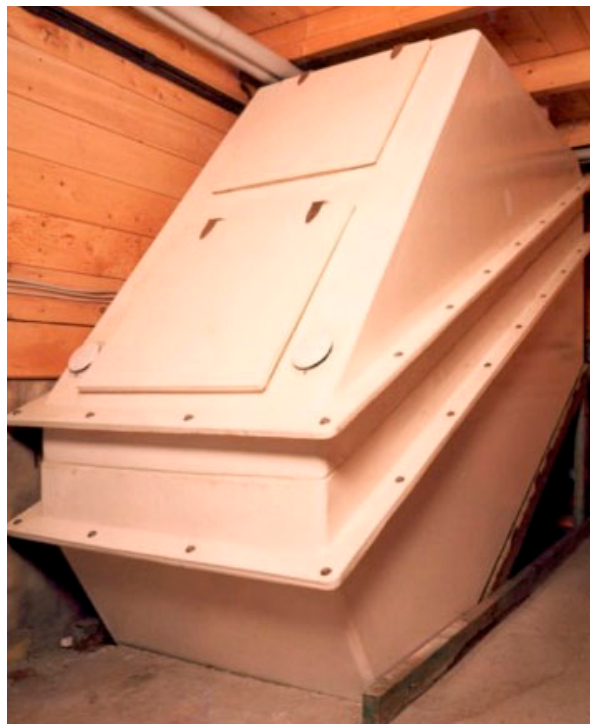
Abb. 7.10: Komposter unterhalb einer Toilette im Keller-raum [Berger, 2003]
