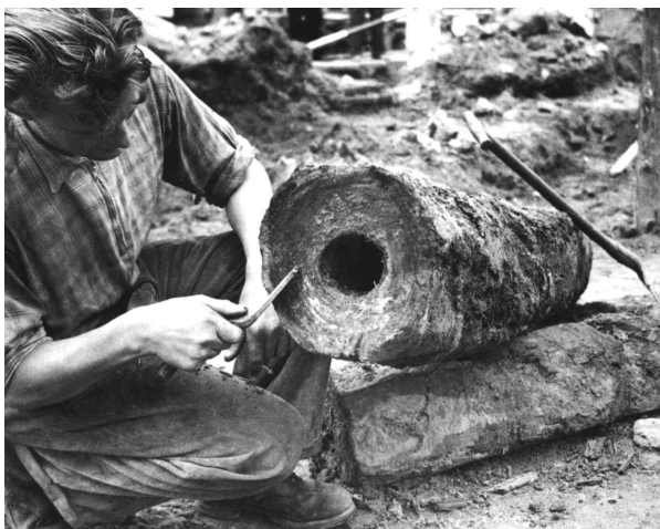
Abb. 1.3: Bei Erdarbeiten in Braunschweig freigelegte Pipen [Veh und Rapsch, 1998]
