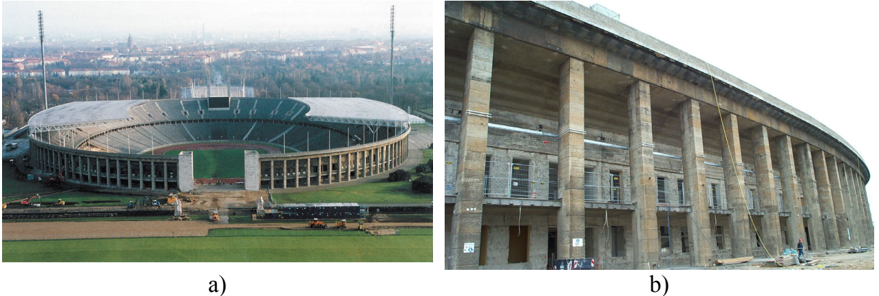
Bild 7.27 Äußerer Stützenring des Berliner Olympiastadions a) Gesamtansicht, b) Umlaufende Stützen
