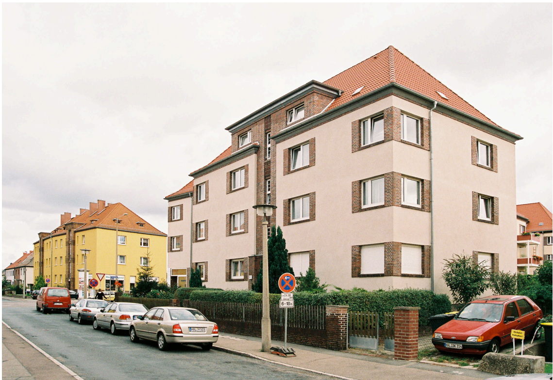
Abb. VI.III.III-8: Mehrfamilienwohnhaus in der Benkendorfer Straße 20 in Halle. Die Aufnahme entstand 2007.
