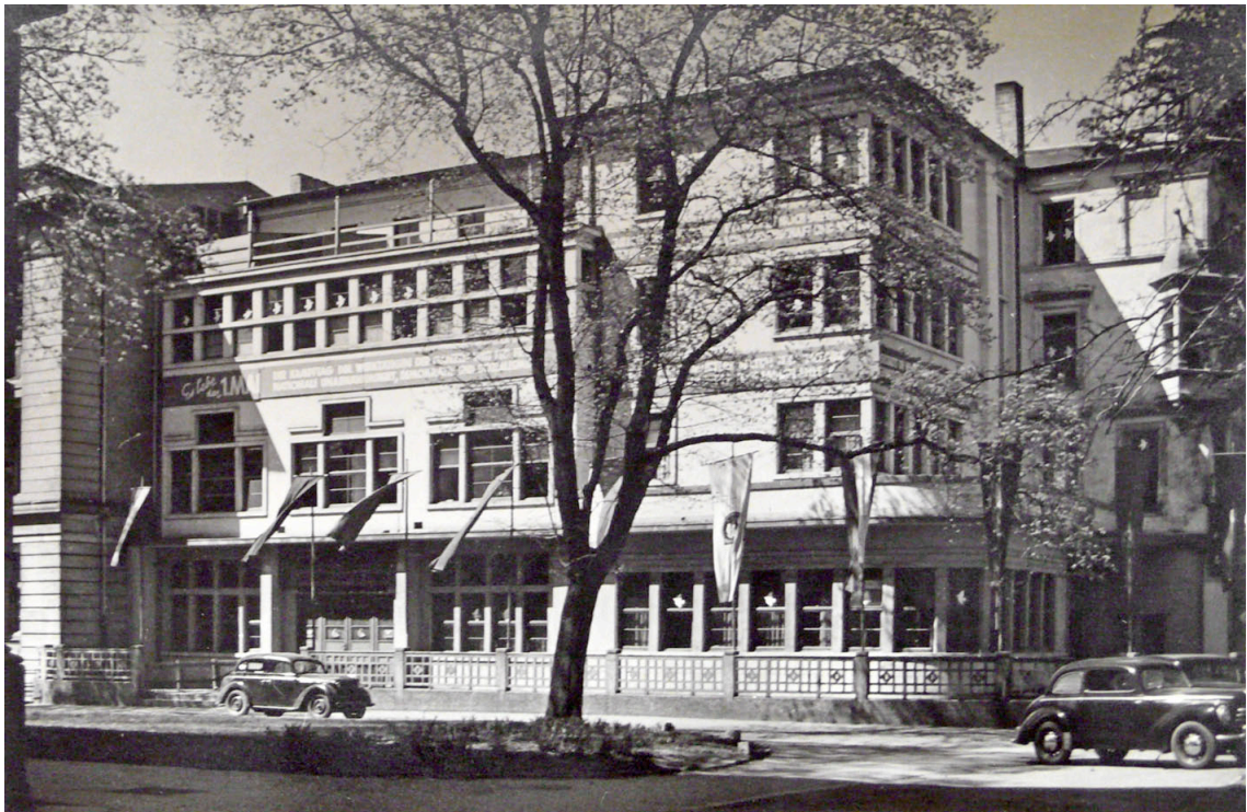
Abb. VI.III.III-64: Um- und Erweiterungsbau der akademischen Speiseanstalt im Universitätsring 5 in Halle. Die Aufnahme entstand um 1950.
