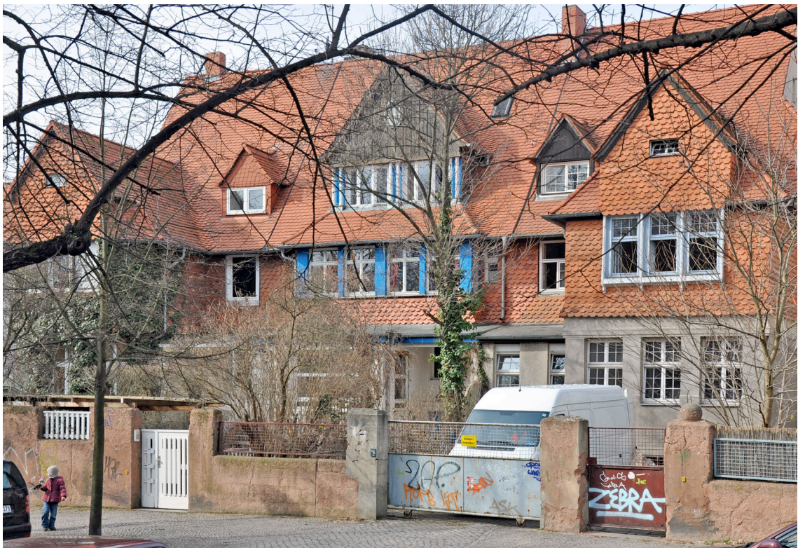
Abb. VI.III.III-84: Wohnhaus am Rathenauplatz 3 in Halle. Die Aufnahme entstand 2011.
