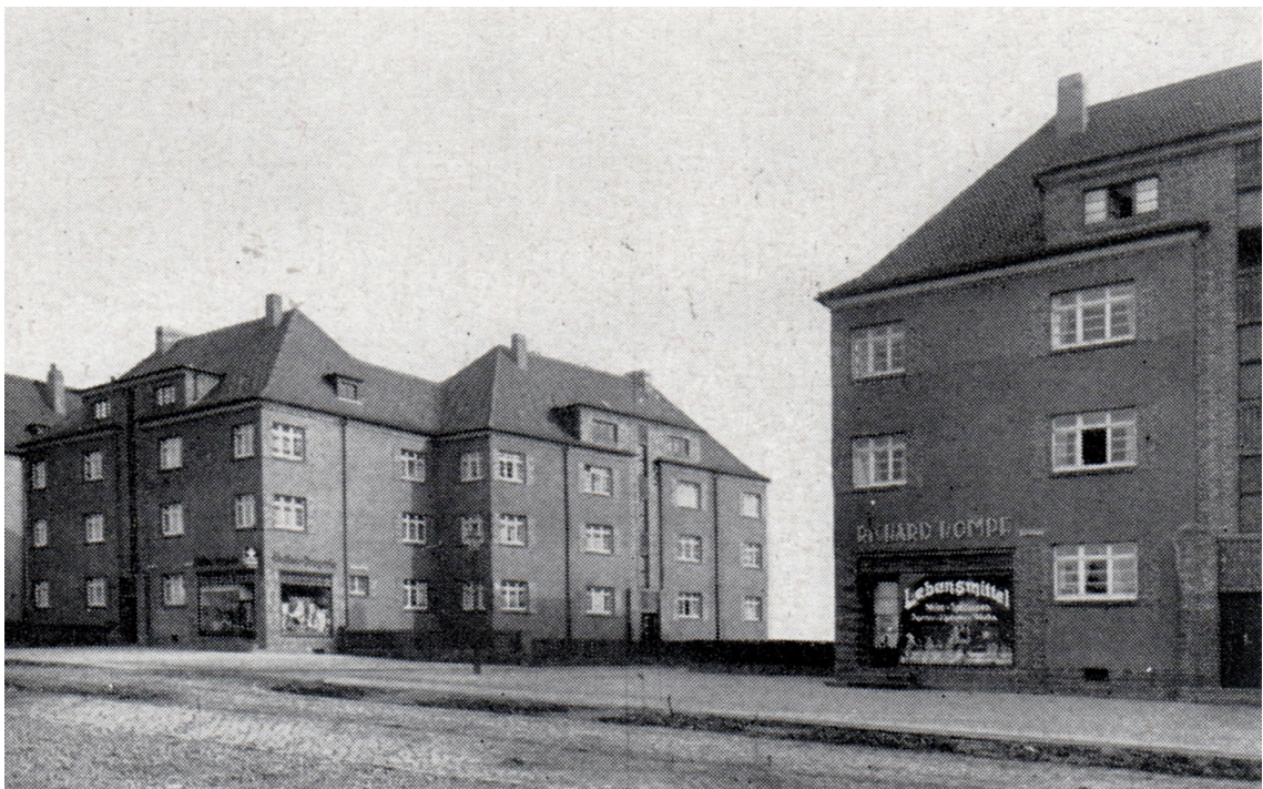
Abb. VI.III.III-1: Mehrfamilienwohnhaus im Ammendorfer Weg 1 in Halle. Die Aufnahme entstand um 1928.
