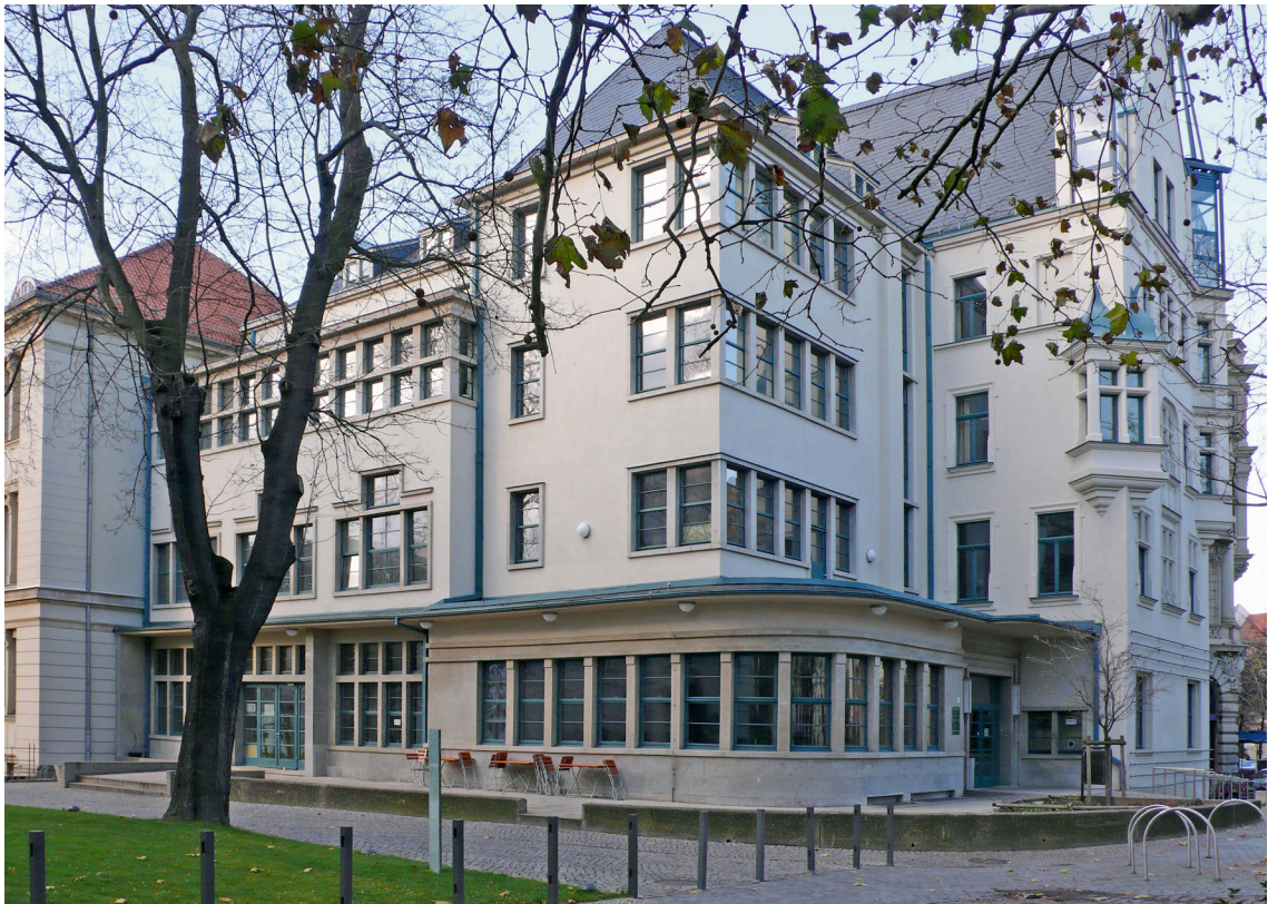
Abb. VI.III.III-58: Um- und Erweiterungsbau der akademischen Speiseanstalt im Universitätsring 5 in Halle. Die Aufnahme entstand 2007.
