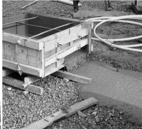
Bild 5 Probeeinbau von selbstverdichtendem Beton im freien Fall aus großer Höhe (links)
