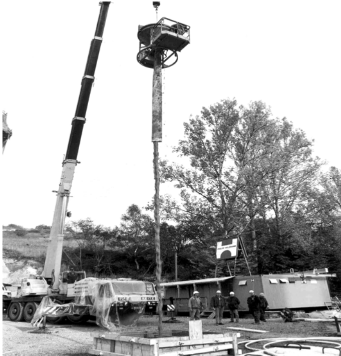
Bild 5 Probeeinbau von selbstverdichtendem Beton im freien Fall aus großer Höhe (links)
