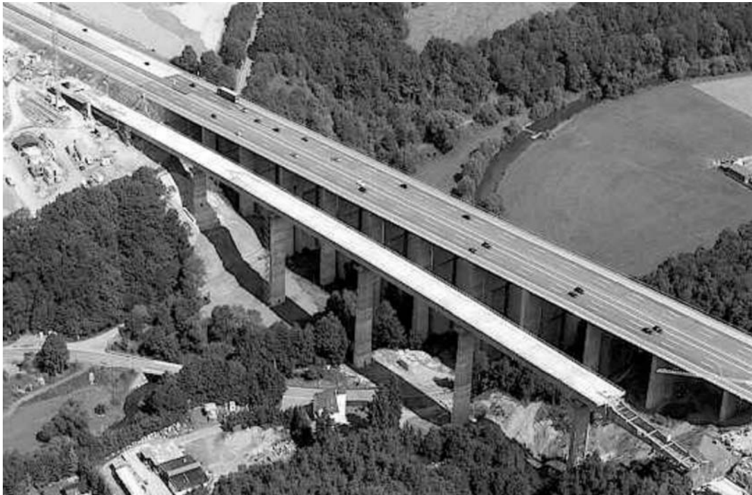
Bild 3 Talbrücke Wied, Widerlager Frankfurt (Aufnahme vom 17.07.1999)
