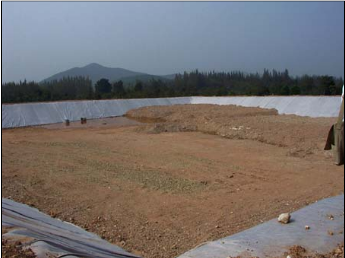
Abbildung 5.2: Im Bau befindliche Deponie Lamphun
